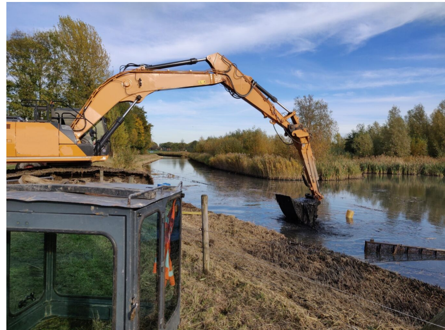
Foto: Baggeren zorgt voor een betere doorstroming, minder stankoverlast en een betere waterkwaliteit
