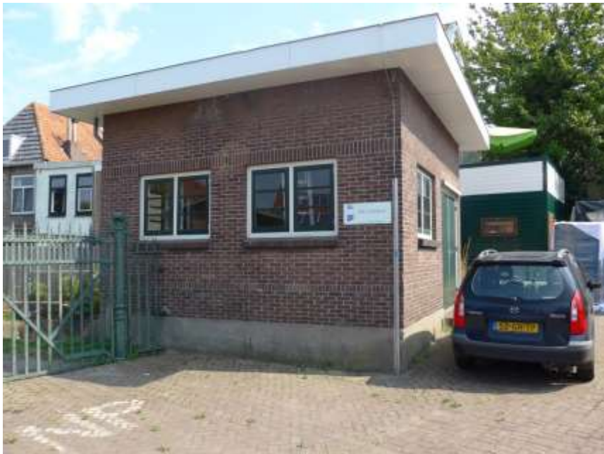
Figuur 10: Gemaal Het Oudeland te Ooltgensplaat
