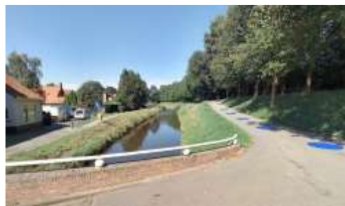
Figuur 26: Wateraanvoer naar gemaal Het Oudeland langs de Dorpsdijk
