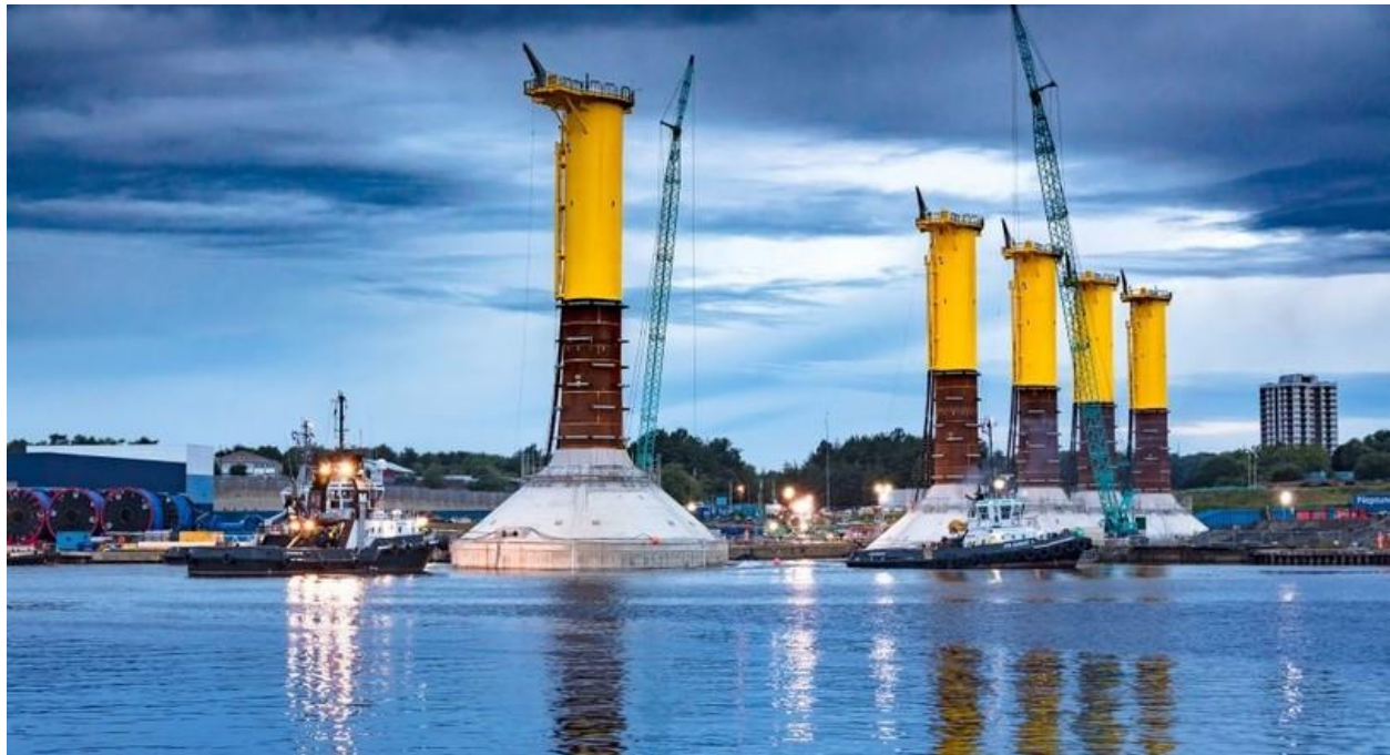
Vijf betonfunderingen van windturbines zijn op weg naar zee om daar af te zinken: Betonvoet: doorsnede 30 m en 20 m hoog. Betonvoet en stalen buispaal: 60 m hoog.
